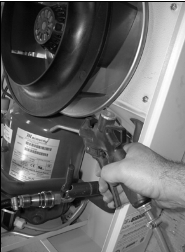
Abb. 52: Wärmetauschregister und Kompressorraum mit Druckluft ausblasen (2)
