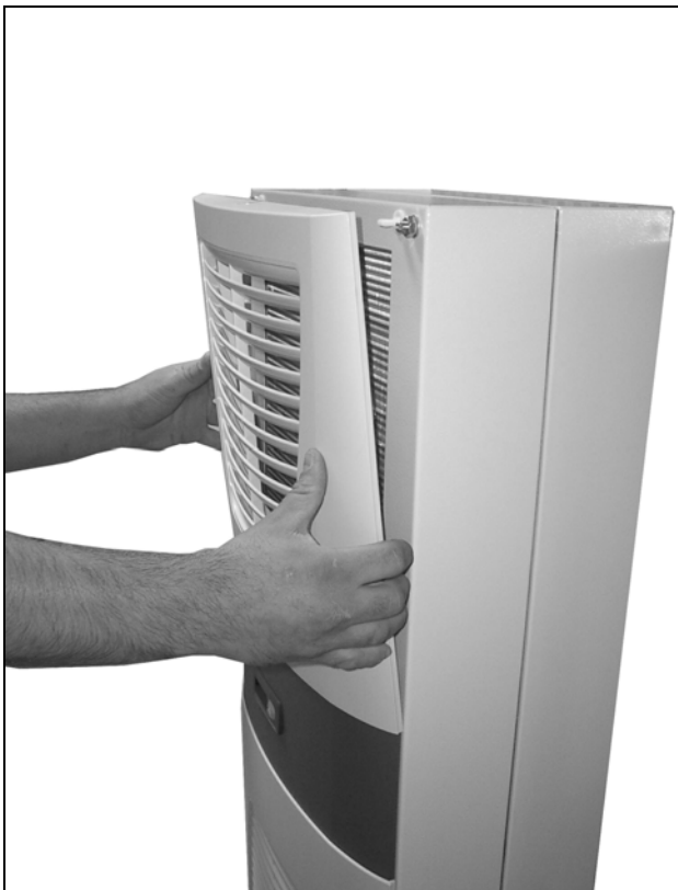
Abb. 35: Oberes Lamellengitter entfernen
