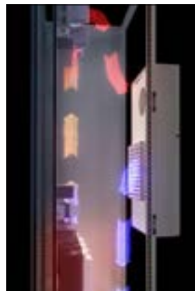
Beispiel der Luftumlenkung für Blue e+ Kühlgeräte
