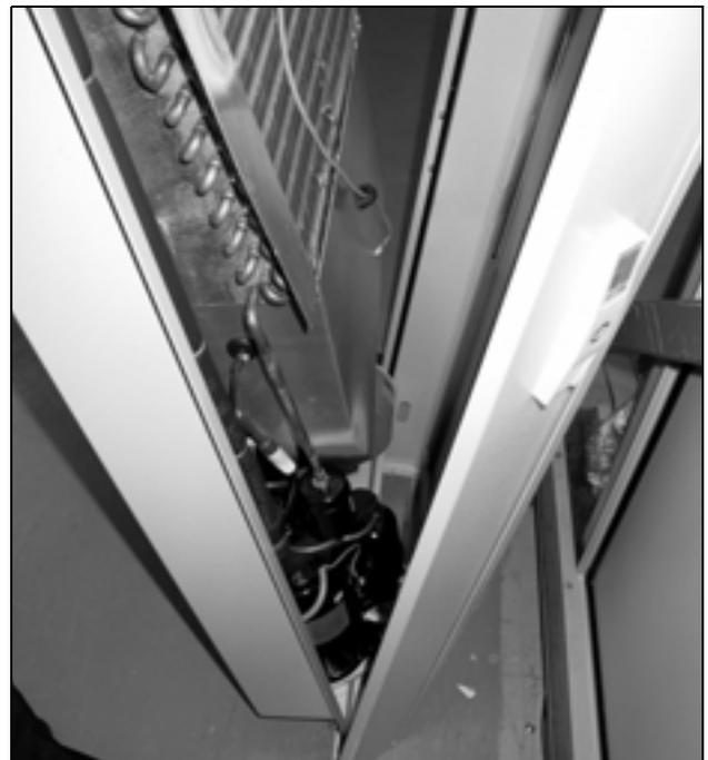
Abb. 8: Montage des Klimamoduls in die Profiltür
