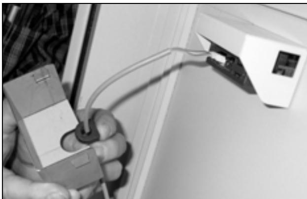
Abb. 16: Kabeltülle einführen
