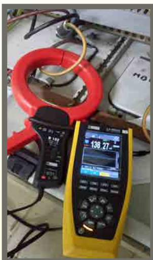
Messung mit einer Leckstrom-Messzange und Aufzeichnung des Fehlers.
