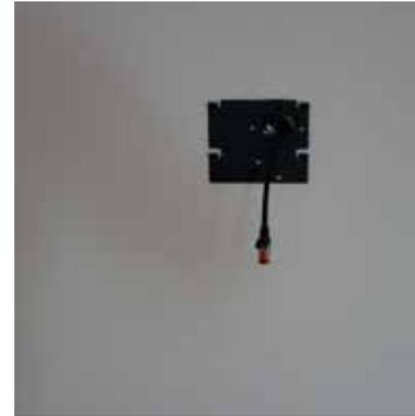
Montieren Sie den Monitorhalter mit den Gehäuseschrauben auf die Leerdose.
