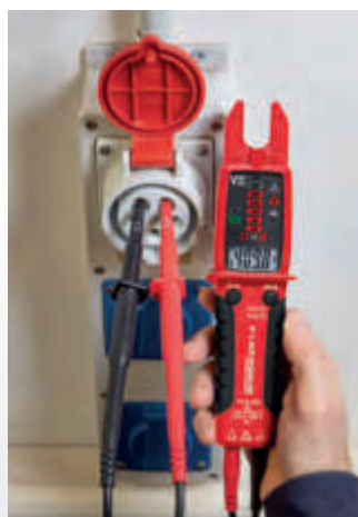
Spannungsmessung und Drehfeldrichtungsprüfung
