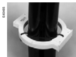
Montage sur les câbles MT.
