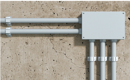
Befestigung von Kabelschellen/Verteilerdosen
