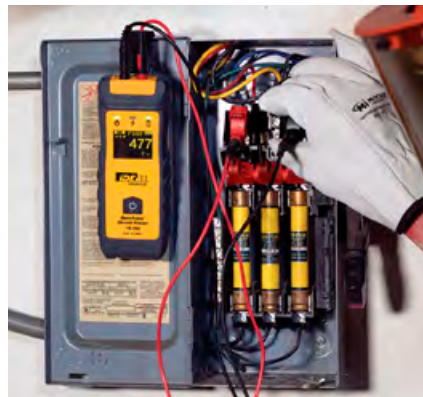
Einzelne Leiter können sortiert, offene Adern und Kurzschlüsse können einfach lokalisiert werden.
