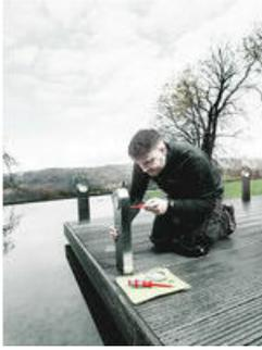
Warum sieht man eigentlich so oft Edelstahlelemente mit Rostbefall? Ein Grund: Häufig wird mit Werkzeug aus "normalem" Stahl verschraubt, was Fremdstrost erzeugen kann. Das ist ärgerlich. Wir waren überzeugt, dass man das verhindern kann. Durch Schraubwerkzeuge, die ebenfalls aus Edelstahl sind und die notwendige Industriestandard-Härte haben. Fremdstrostbefall wird verhindert, eine spezielle Vakuumeishärtung sorgt für die notwendige Härte. In VDE-Ausführung.
