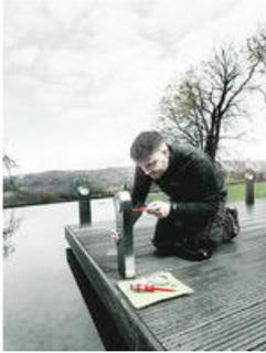
Warum sieht man eigentlich so oft Edelstahlelemente mit Rostbefall? Ein Grund: Häufig wird mit Werkzeug aus "normalem" Stahl verschraubt, was Fremdrost erzeugen kann. Das ist ärgerlich. Wir waren überzeugt, dass man das verhindern kann. Durch Schraubwerkzeuge, die ebenfalls aus Edelstahl sind und die notwendige Industriestandard-Härte haben. Fremdrostbefall wird verhindert, eine spezielle Vakuumeishärtung sorgt für die notwendige Härte. In VDE-Ausführung.
