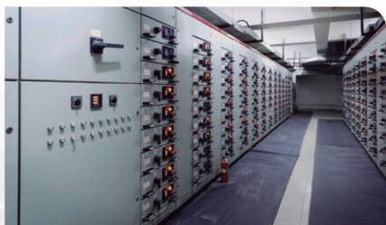
Monitoramento Contínuo de Equipamentos Críticos
