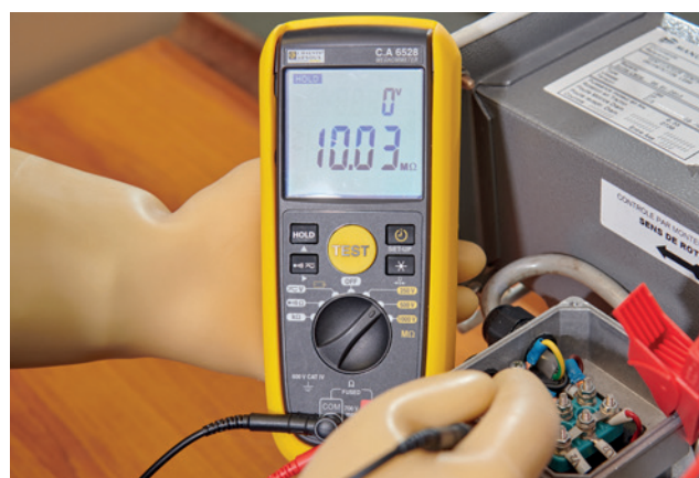
Mantenimiento preventivo en un motor
