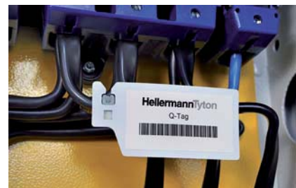
Le marquage des plaquettes Q-tags peut être réalisé avec des étiquettes imprimées ou à la main.
