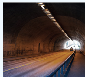
Surveillance de tunnel
