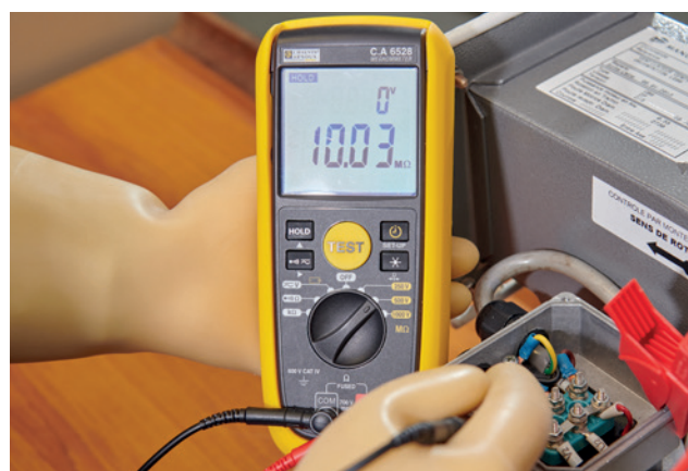
Maintenance préventive sur moteur
