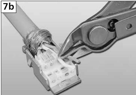
... und die Kabeladern bündig abschneiden.
