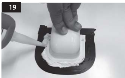
19 Applicera tätningsmassa runt kabelhuset.
