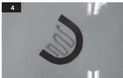
4 Lägg monteringsplattan åt sidan för att lägga tätningsmassa inom det tejpadet området.
