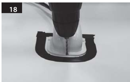
Placera kabelhuset i tejpmarkerat område, borra 3 st 2 mm borrhål.
