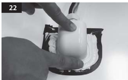
22 Snygga till tätningsmassan.
