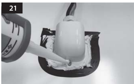
21 Lägg tätningsmassa runt och ovanpå skruvarna.
