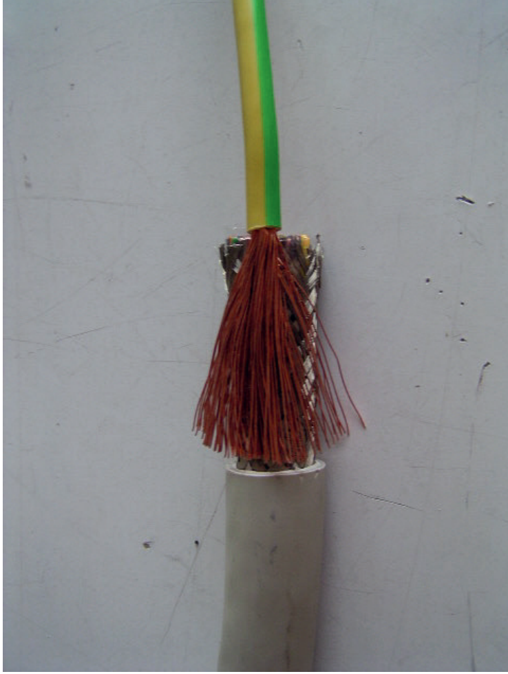
Bild. 3.2: Drähte des PE auseinander fächern und auf die Schirmung legen.
