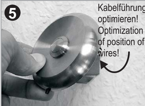
Klingeltaster oben einhängen Fixation of push on bracket
