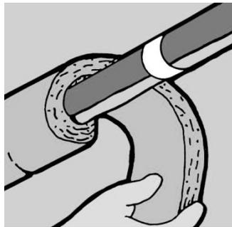
Bevor Sie das Heizkabel anbringen, stellen Sie sicher, dass der Bereich am und um das Rohr frei von scharfen Kanten und brennbaren Materialien ist. Entfernen Sie alte Heizbänder, bevor Sie weitermachen, und verwenden Sie eine Feile, um scharfe Kanten zu entfernen.
