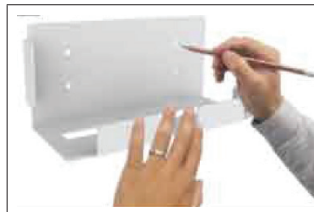
Zeichnen Sie die Bohrlöcher an.
