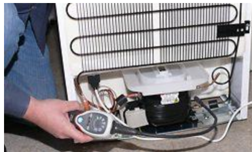
Lecksucher im Einsatz an einem Kühlsystem
