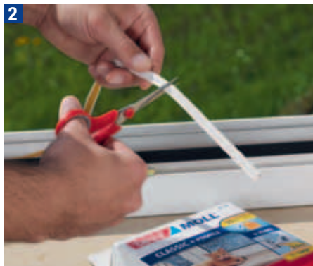
2 Dichtung auf die richtige Länge zuschneiden
