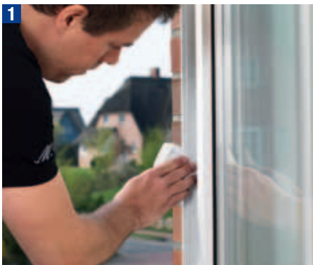
1 Fensterrahmen gründlich säubern und trocknen lassen
