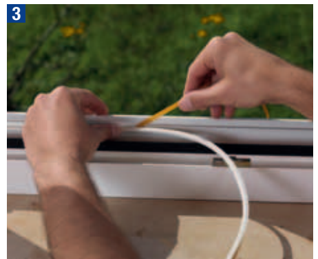
3 Dichtungstreifen kräftig im Rahmen andrücken
