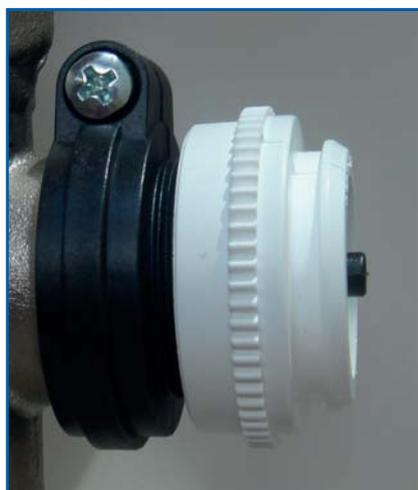
**Bild 5** | Kupplungsring handfest aufschrauben (ohne zusätzliches Werkzeug).
