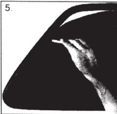
5. Um die vorhandene Flüssigkeit zwischen Folie und Scheibe herauszudrücken, streichen Sie mit dem Gummirakel von der Mitte aus vertikal und horizontal die Folie glatt.
