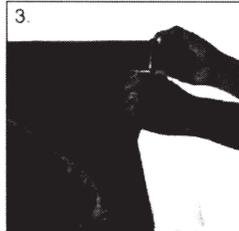
3. Die jetzt von der Schutzfolie befreite Seite der Folie mit der Seifenlösung mit Hilfe einer Sprühflasche besprühen. Die Folie muss gleichmäßig benetzt sein.
