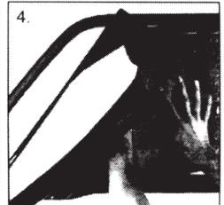
4. Die Folie wird jetzt mit der angefeuchteten Klebeseite auf die Scheibe gebracht und lässt sich leicht in die gewünschte Position bringen.
