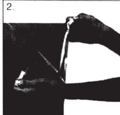
2. Die transparente Schutzfolie entfernen Sie, indem zwei Klebebandstreifen gegeneinander an einer Folienecke innen und außen auf die Folie geklebt und sodann auseinandergezogen werden.
