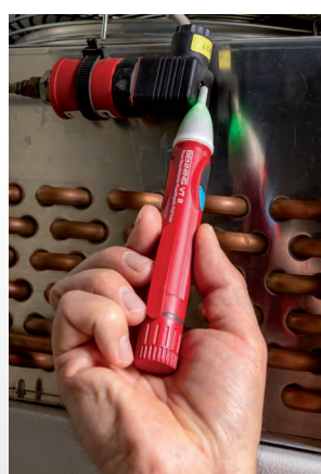
een magneetklep testen
