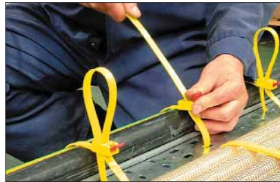
Overlengten kunnen weggestoken worden.
