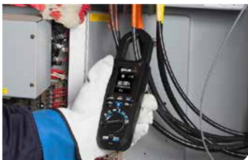
Controleren van stroommetingen
