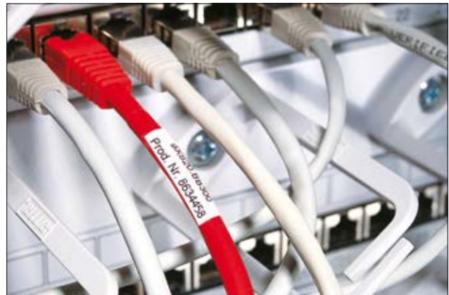
Zelflaminerende labels bieden bescherming tegen slijtage en omgevingsinvloeden.
