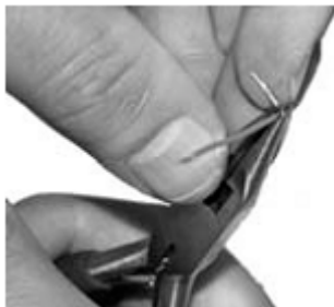
Ryc. 29: Przewód wygięty za pomocą okrągłych kleszczy elektrycznych.
