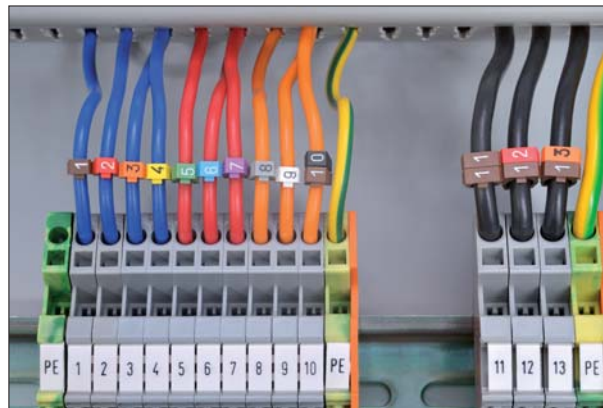
Bezpieczna metoda czytelnego oznaczenia przewodów bez ich rozłączenia.
