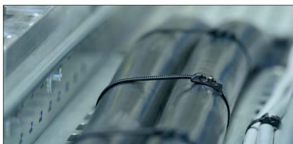
Opaski Robusto są zalecane do mocowania w korytach kablowych.
