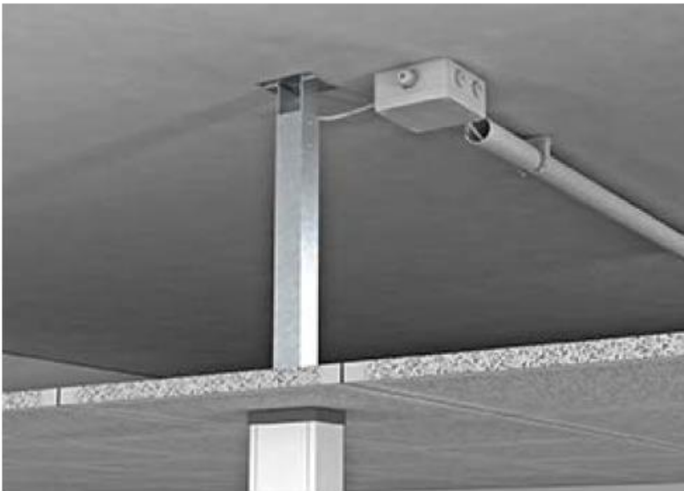
Rysunek 31 Całkowicie zmontowane kolumny montażowe z blachy stalowej w obszarze sufitu
