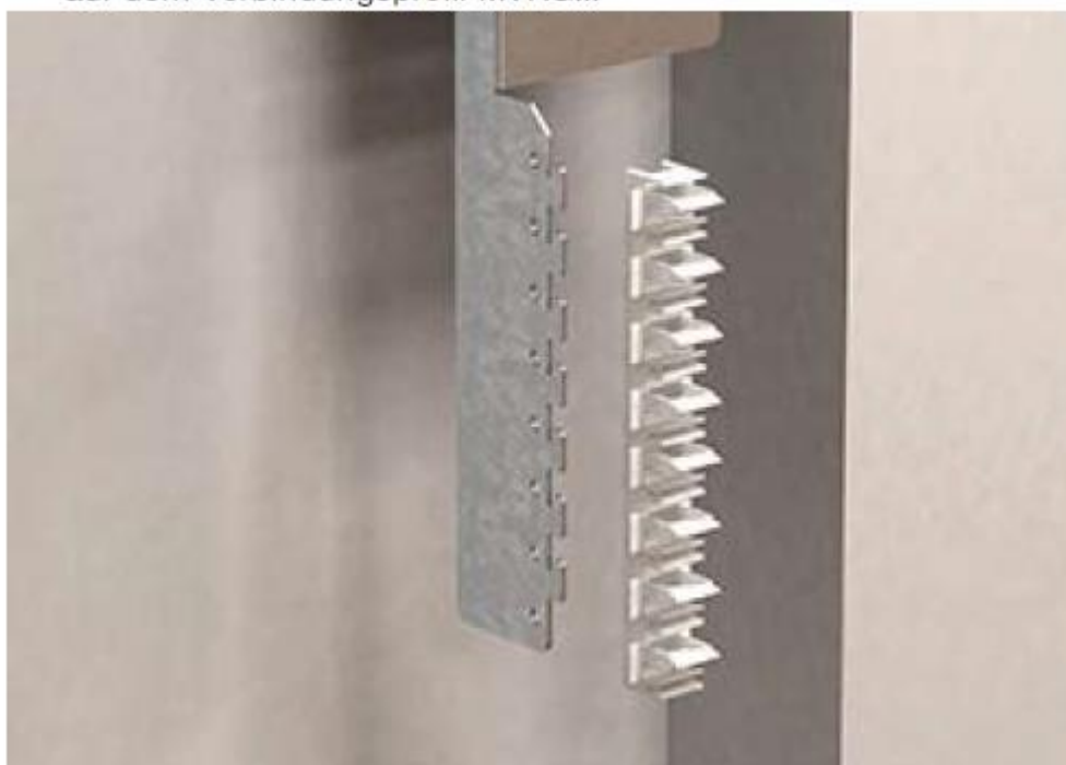
Rysunek 9 Montaż łączników profili pionowych
