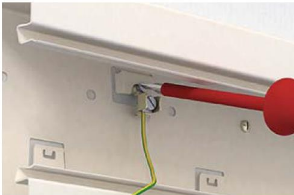
Rysunek 51 Kąt podłączenia przewodu ochronnego w kanale GS
