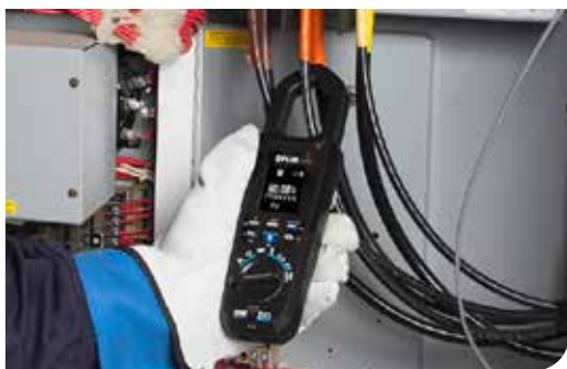
Измерение амперной нагрузки
